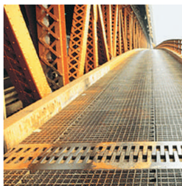
Рис. 2.6. Щоб міст не вигинався під час спеки й не руйнувався в мороз, його виготовляють з окремих секцій, з'єднаних спеціальними зчленуваннями (ряди зубців змикаються під час спеки й розходяться під час морозів)
