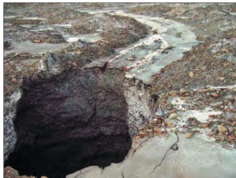
Мал. 2. Карстове провалля на автомобільній дорозі в Івано-Франківській області.
