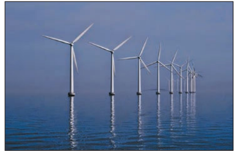
Мал. 2. Шельфова вітрова електростанція Лілгранде (Швеція) має високу ефективність через регулярний морський вітер. Електроенергія передається на землю через підводні кабелі.
