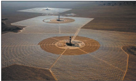
Мал. 1. Сонячна електростанція Іванпа (США) — одна з найбільших у світі. Вона складається зі 173 тис. дзеркальних модулів. У центрі електростанції розташовані три високі вежі, на вершині яких дзеркала-геліостати відбивають сонячні промені.
