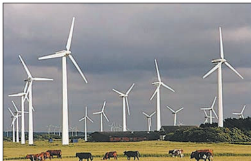
Мал. 4. Ботівєвська ВЕС — найбільша вітрова електростанція України, розташована поблизу села Приморський Посад (Запорізька обл.). Завдяки великій протяжності узбережжя, досвіду проектування, будівництва й експлуатації ВЕС, серійному виробництву обладнання та державній підтримці Україна має добрі перспективи використання енергії вітру.
