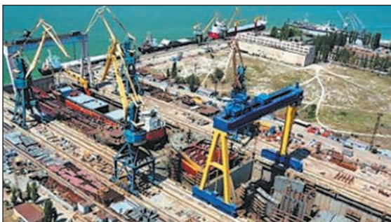
Мал. 5. Миколаївський суднобудівний завод «Океан». Його потужності розраховані на будівництво та ремонт великих середньотоннажних і великотоннажних суден різного класу й призначення.
