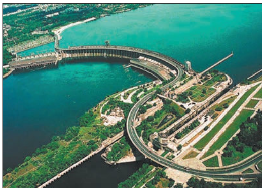
Мал. 3. Дніпровська гідроелектростанція (Дніпрогес) — найстаріша з каскаду ГЕС на річці Дніпро. Розташована в місті Запоріжжі. Для отримання електроенергії тут побудовано греблю, яка перекрила течію річки і підняла рівень води в ній. Вода падає з висоти і змушує обертатися гідравлічні турбіни, що виробляють електроенергію.
